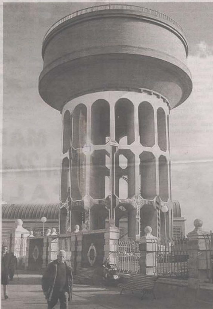
El depósito elevado de la Fundación Canal rompe ahora la rutina visual de la zona
